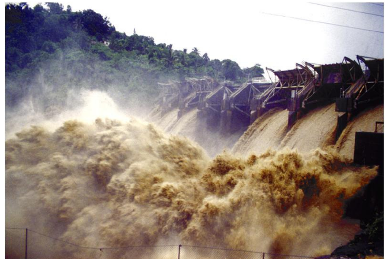
Figura 11. Las compuertas del embalse Loíza (Represa Carraízo) se abren luego de las intensas lluvias durante el Huracán Hortense, 1996 (foto por Mathew Larsen, USGS, 1996).
